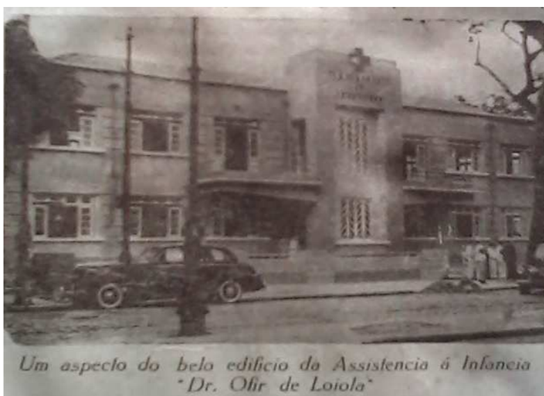
Foto 7 - Edifício da Assistência à Infância
